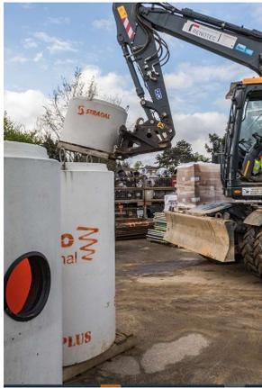
Les décanteurs **DDSELECT™ Ø1000 et Ø1200** sont livrés en plusieurs parties et **sur palettes** (1 élément par palette)
