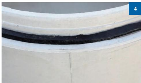
Raccorder le joint bout à bout en liant par modelage et sans chevauchement les deux extrémités.
