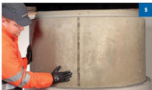
Descendre verticalement l'élément supérieur en le centrant à l'aide du trait de repérage des échelons par rapport à l'élément inférieur et ce, jusqu'au contact avec le joint plastomère. A l'aide d'une pièce de bois, exercer une pression verticale uniforme pendant 1 min au moins sur l'élément supérieur pour assurer l'étanchéité de l'assemblage.
