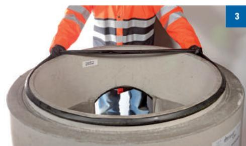
Poser le joint sur sa portée béton comme indiqué sur la photo. Mettre le joint en place sur l'épaulement supérieur de l'emboîture mâle.
