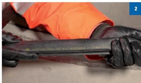
Préparer le joint en veillant à ce que les inscriptions soient sur la face extérieure et à l'envers. **Ne jamais graisser le joint ni l'emboîtement femelle.**
