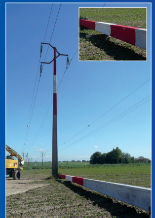
Identification du poteau dans un couloir aérien sur demande
